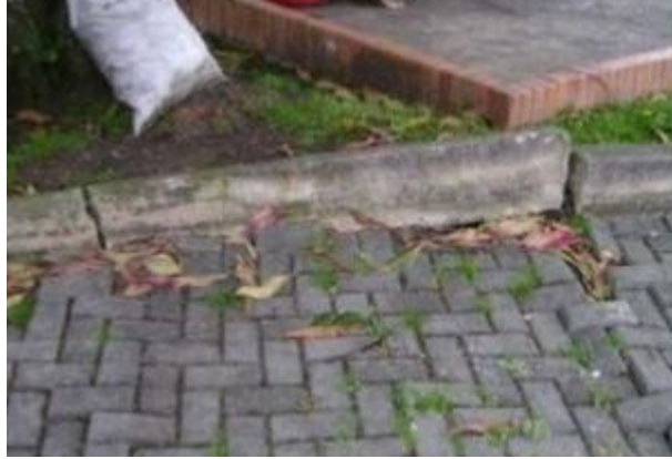
Fig. 47. Fracturamiento de confinamientos externos
