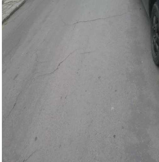
Fig. 24. Grietas Parabólicas
