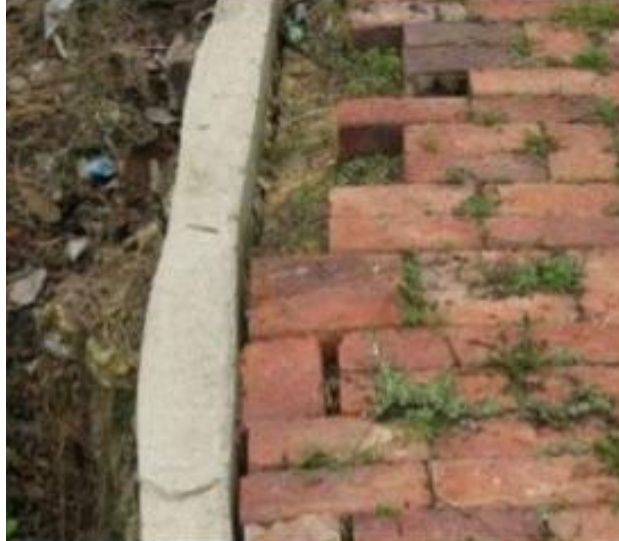
Fig. 44. Desplazamiento de Borde
