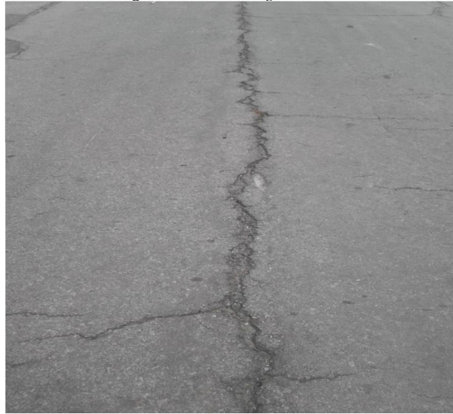
Fig. 15. Grietas longitudinales
