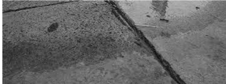
Fig. 36. Escalonamiento de Junta
