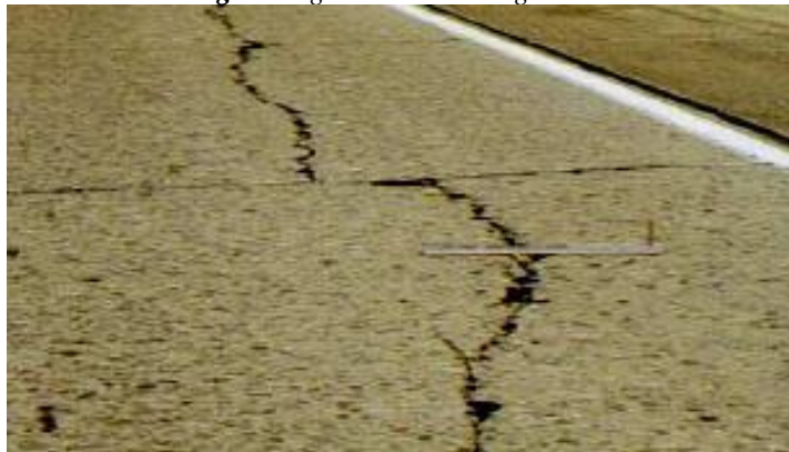
Fig. 32. Agrietamiento Longitudinal
