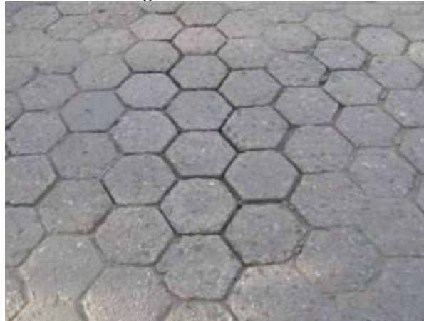
Fig. 51. Juntas abiertas
