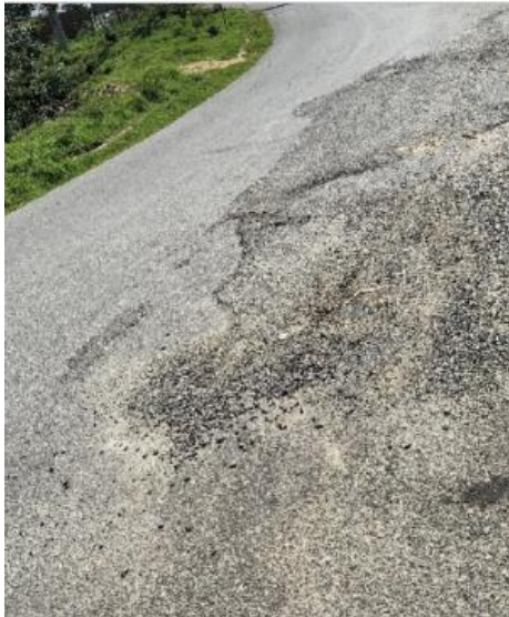
Fig. 26. Meteorización
