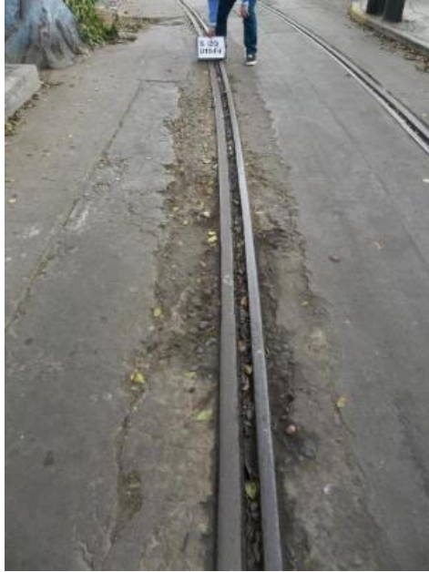
Fig. 21. Cruce de Vía Férrea
