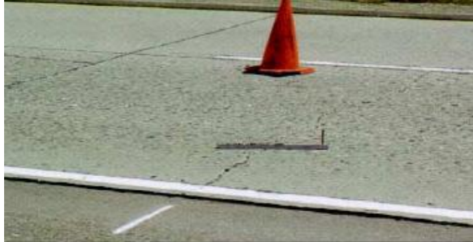
Fig. 31. Agrietamiento Transversal
