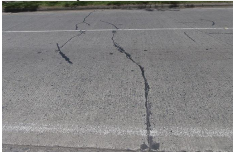
Fig. 16. Grietas transversales
