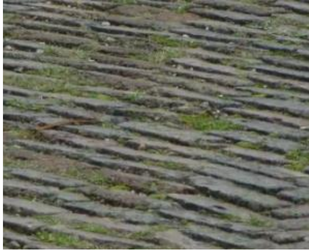
Fig. 49. Escalonamiento entre adoquines
