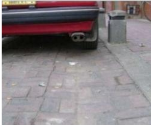
Fig. 40. Ahuellamiento
