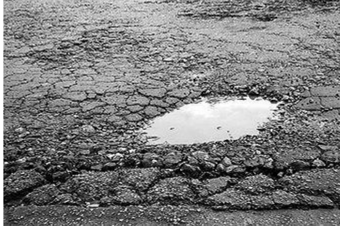
Fig. 34. Desintegración
