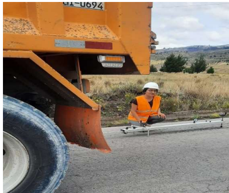
Medición de deflexiones en la vía
