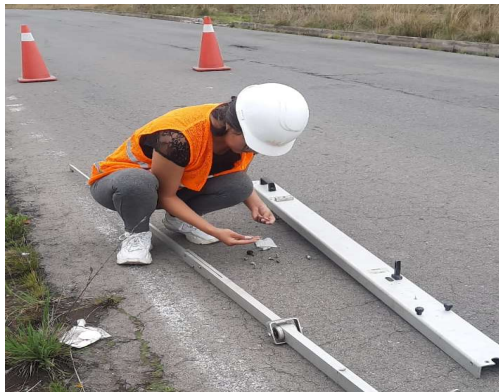
Armado de la Viga Benkelman
