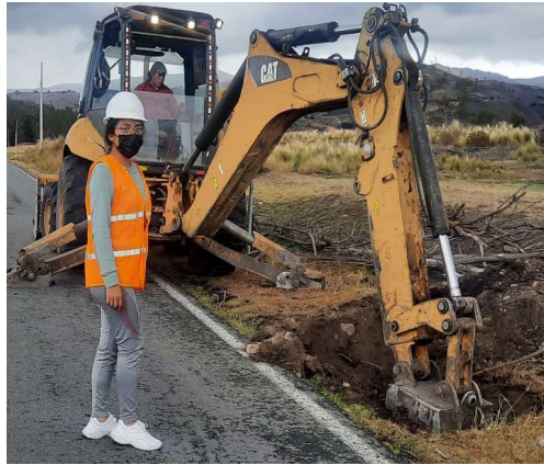
Realización de calicatas con retroexcavadora
