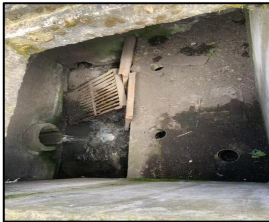
*Figura 6. Cajón repartidor con rejilla de cribado*
