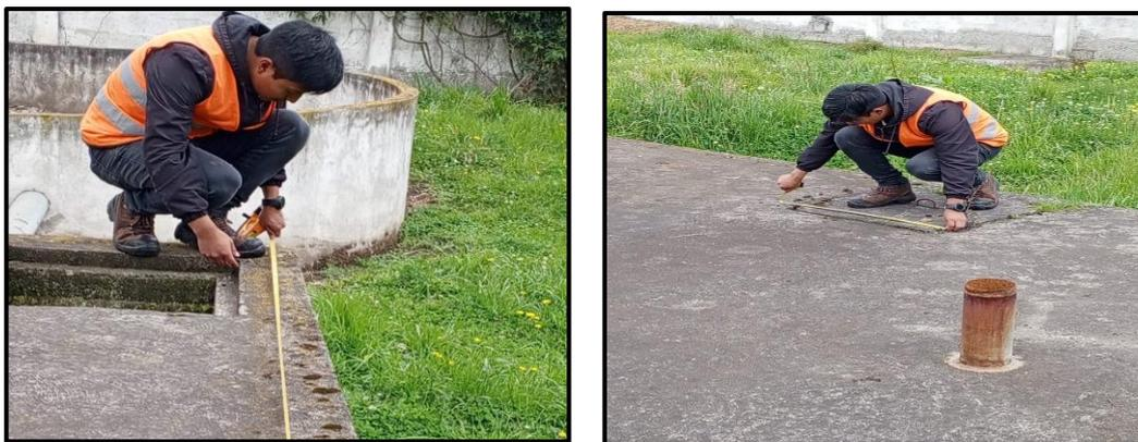
*Figura 10. Dimensionamiento de los componentes hidráulicos de la PTAR*
