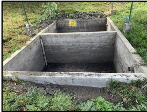
*Figura 9. Lecho de secado de lodos*
