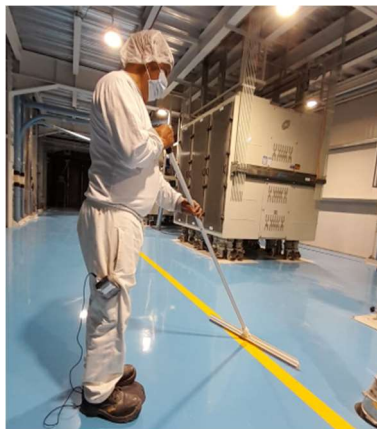
Fotografía 12. Medición de la VTCE en los 3 ejes ortogonales. (Ayudante)
