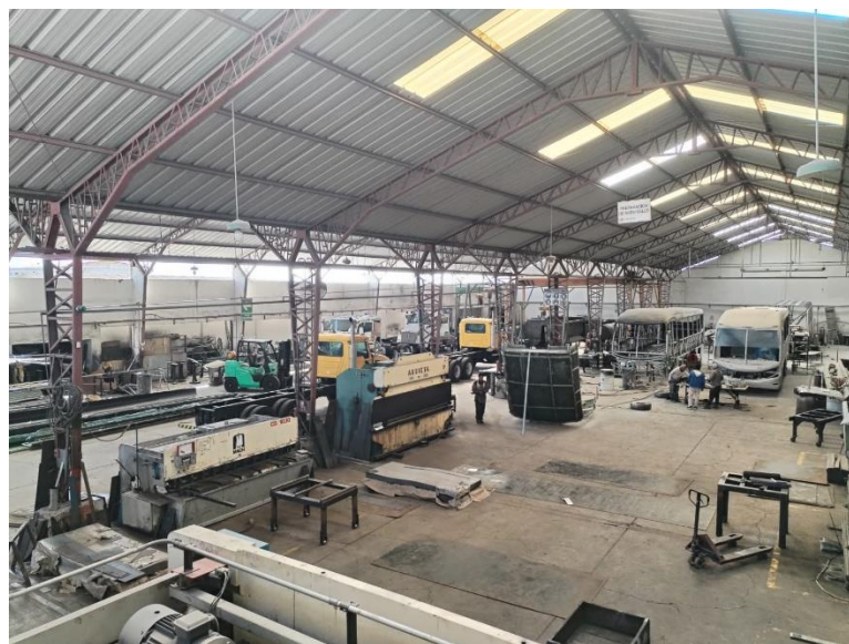
Figura 4. Instalaciones de I.M.ESCO.
