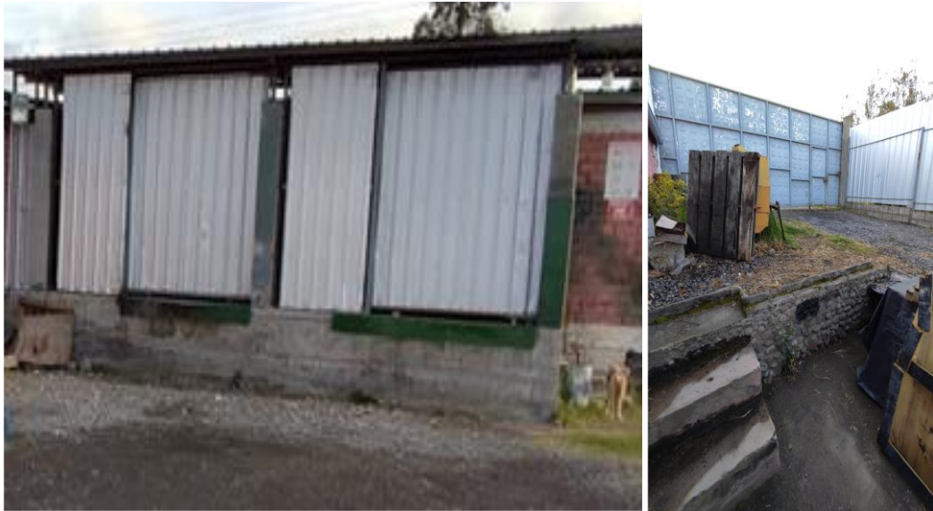
Figura 10. Muelle de carga y descarga de la empresa
