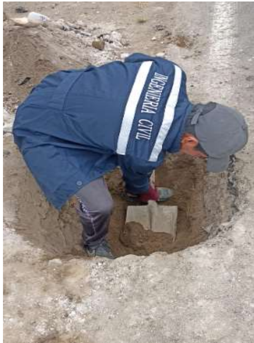
Excavación de la calicata
