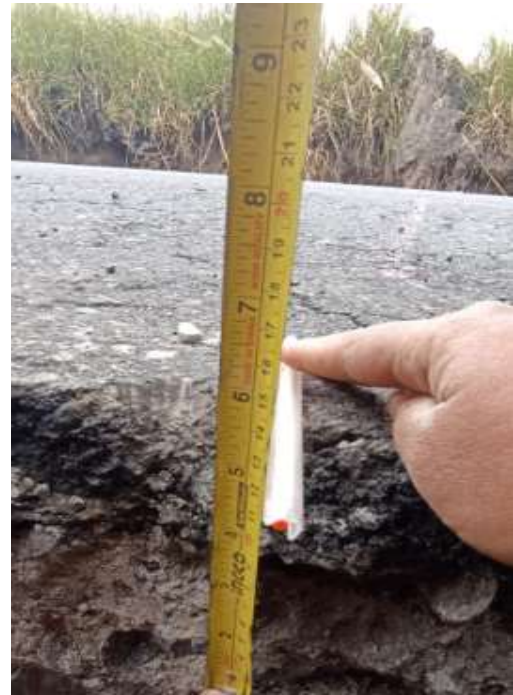
Medición de los componentes de la estructura
