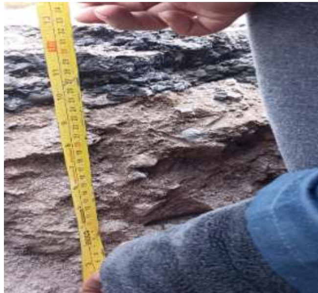
Figura 2: Estructura presente en la vía Pelileo - Guayaquil Autoría Propia
