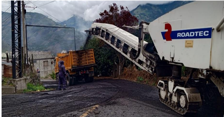
Fig. 14 Obtención de material asfáltico reciclado
