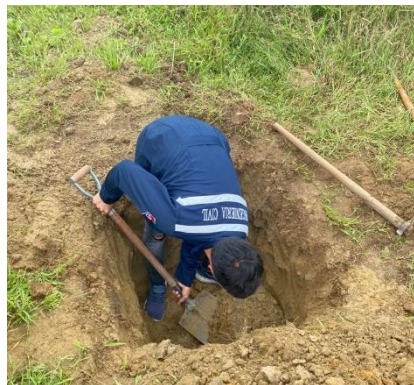
Ilustración 1: Pozo a cielo abierto
