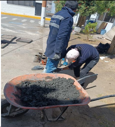
Fotografía 25.- Elaboración de hormigón
