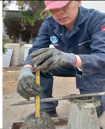
Fotografía 26.- Medición del asentamiento
