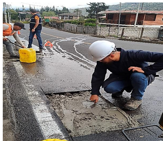
Hormigonado de la segunda cavidad realizada en la vía
