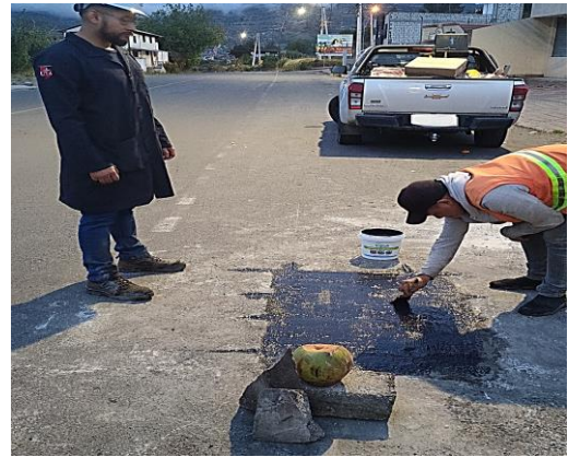
Revestimiento de la superficie hormigonada con una capa de cemento asfáltico líquido, primer punto.
