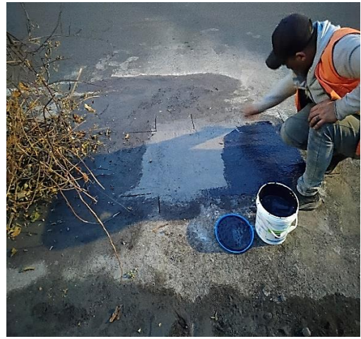
Revestimiento de la superficie hormigonada con una capa de cemento asfáltico líquido, segundo punto
