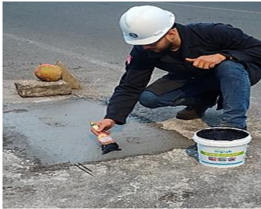
Revestimiento de la superficie hormigonada con una capa de cemento asfáltico líquido, primer punto.
