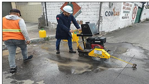
Ilustración N° 0 2.- Corte de asfalto en la vía de estudio
