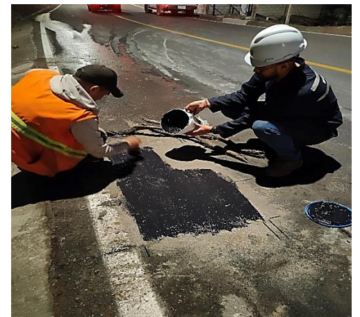
Revestimiento de la superficie hormigonada con una capa de cemento asfáltico líquido, segundo punto
