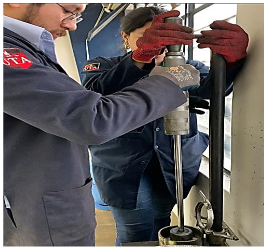
Compactación de la mezcla asfáltica
