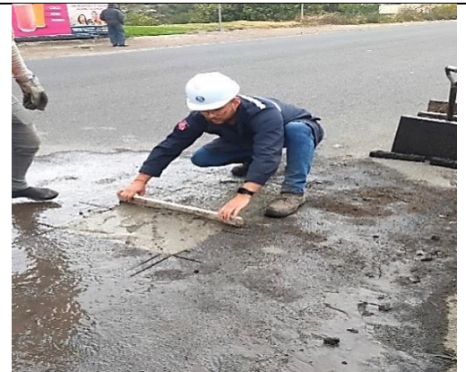
Hormigonado de la cavidad producto de la extracción
