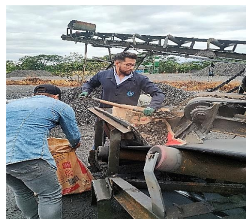
Recolección del pavimento asfáltico triturado
