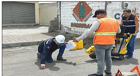
Ilustración N° 0 1.- Área de corte en asfalto
