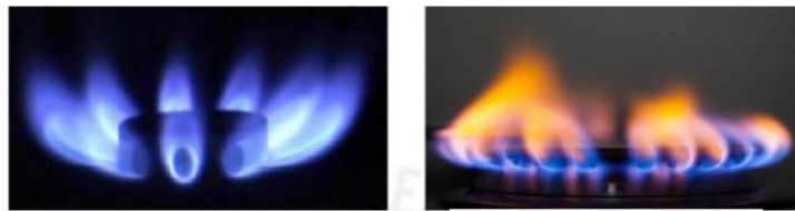
Figura 2: Llama resultante de una combustión correcta vs llama de una combustión incorrecta [6].
