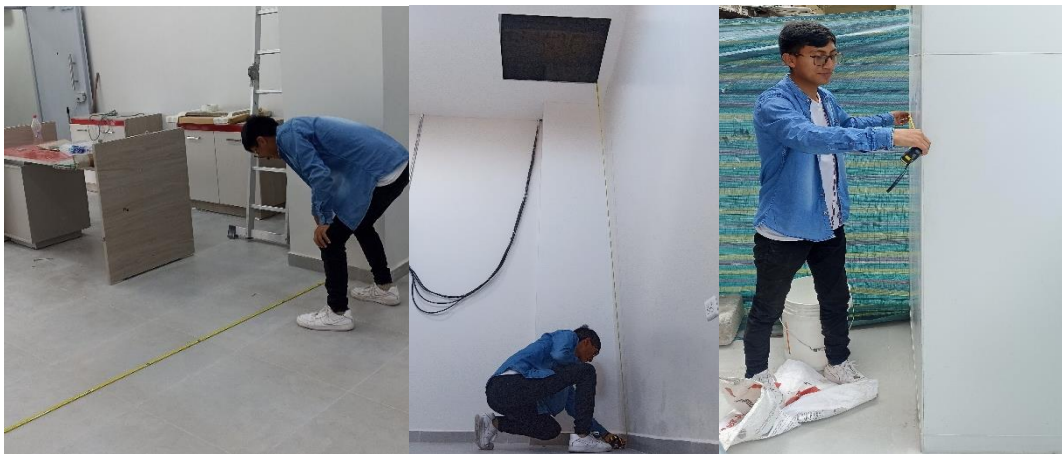
Figura 14. Verificación en obra
