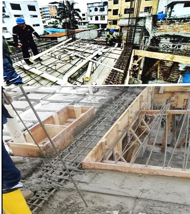
Figura 16. Armado de vigas y losa en obra
