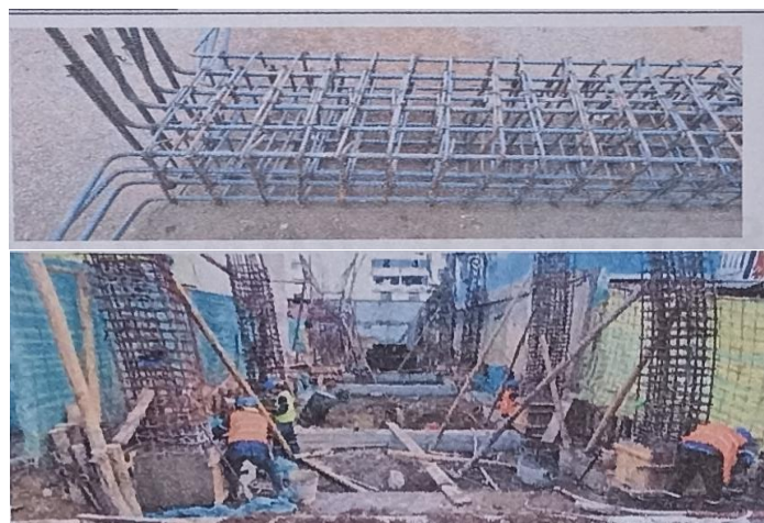
Figura 15. Armado de columnas en obra
