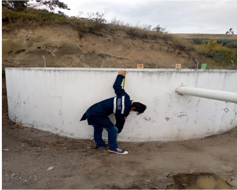
Figura 8. Unidad de tratamiento filtro anaerobio de flujo ascendente.
