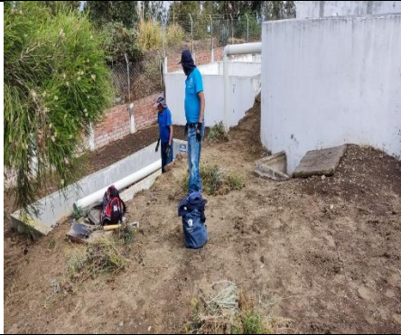
Mantenimiento de la PTAR.
