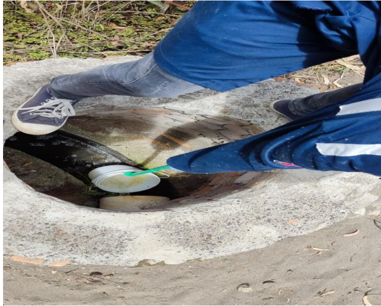
Figura 30. Medición del caudal por el método volumétrico.
