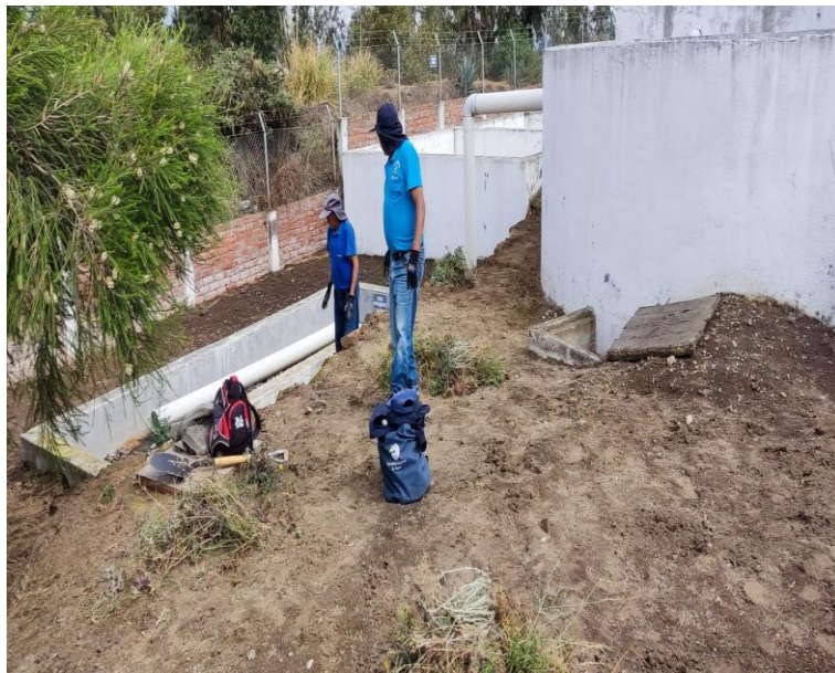
Figura 31. Mantenimiento de la PTAR.
