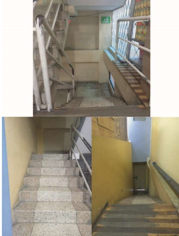
Figura 17. Escaleras en los pisos 2 y 3
