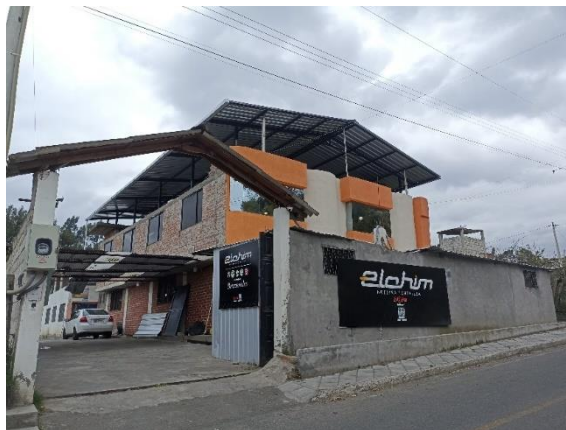
Figura 5. Ingreso principal de Elohimtex Cía. Ltda.
