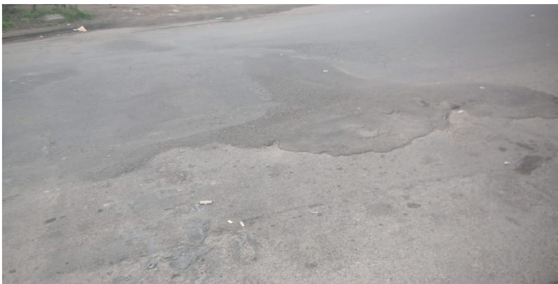
Gráfico 20: Falla desplazamiento
