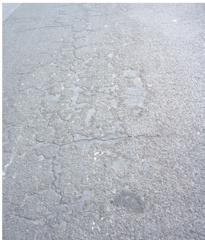
Gráfico 21: Falla Meteorización / Desprendimientos de Agregados
