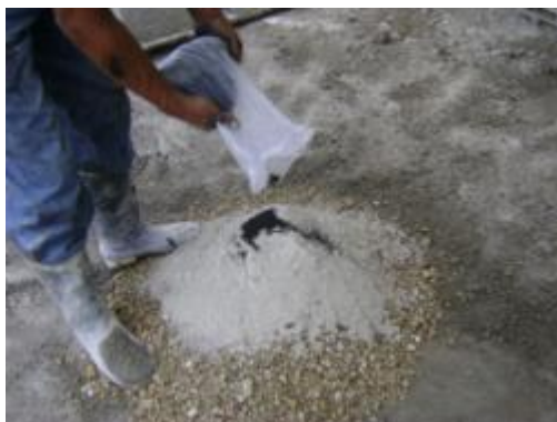
Imagen N° 21 Colocación de los materiales pesados antes de la mezcla
