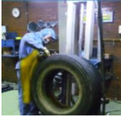
Imagen N° 7. Eliminación de elementos incrustados y reparación
