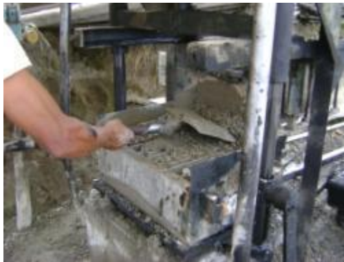
Imagen N° 25 Colocación de la mezcla en la máquina vibro-compactadora
