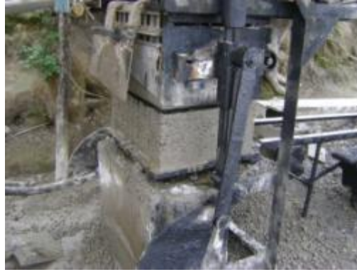
Imagen N° 26 Máquina de vibro-compactación
