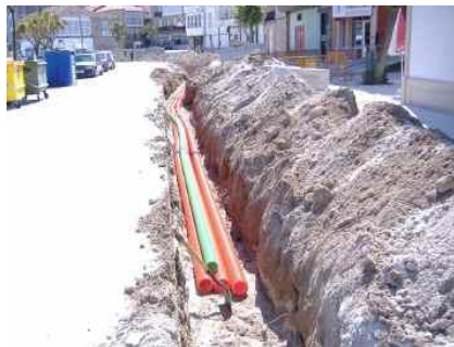
Gráfico N. 9: Canalización enterrada (*)
