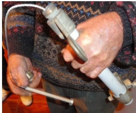
Foto N. 27: Colocación del fusible (*)
