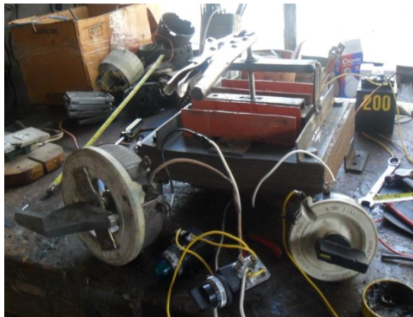
Foto N. 16: Conexiones Internas del sistema de regulación (*)
