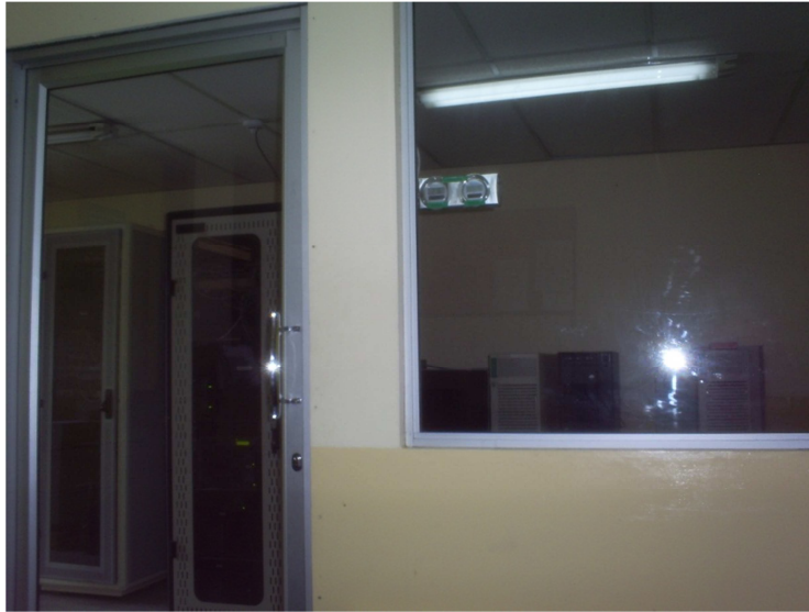
Departamento de Sistemas del Campamento Los Pinos
