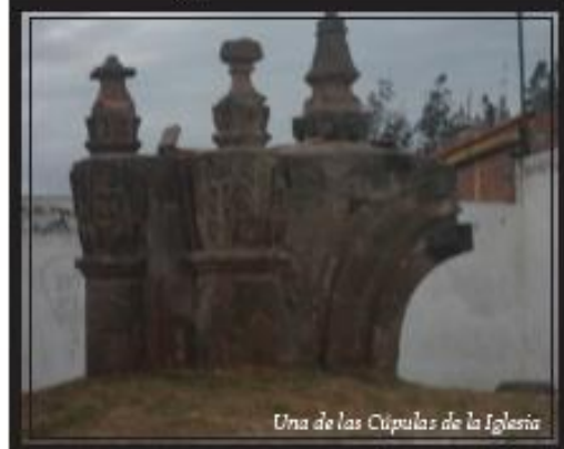
Escombros de la Iglesia Matriz
