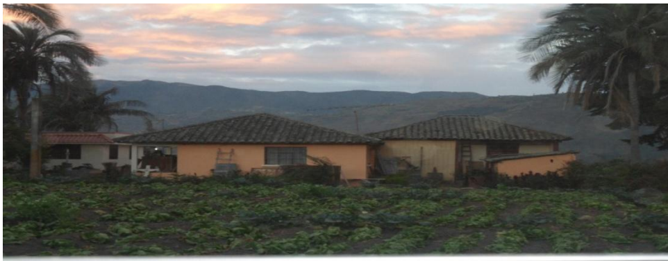
Una de las casas que quedo en pie luego del terremoto
