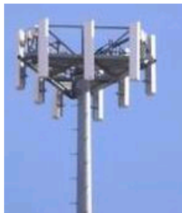
Figura 2.6. Torre de transmisión de telefonía celular
