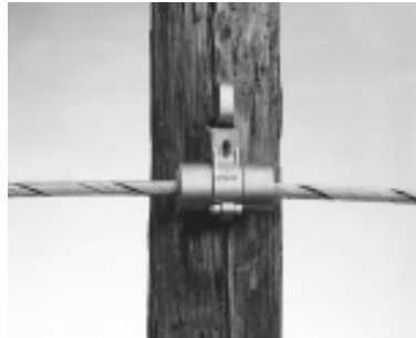
Fig. 2.28 Herrajes de retención.
