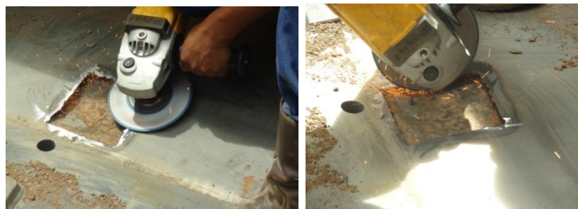
Figura 5.4 Limpieza, desprendimiento de rebabas y preparación de junta y superficie
