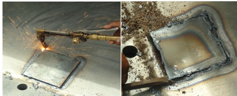
Figura 5.3 Corte y remoción de material desgastado. Fuente: Egdo. Telenchana José Luis.
