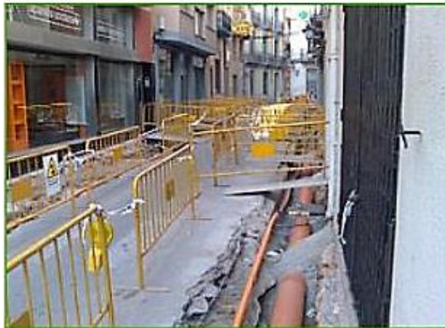
Gráfico N° 8: Tramo de red secundaria en interior de zanja abierta
