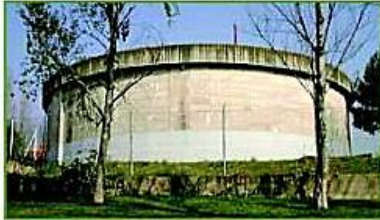
Gráfico N° 6: Deposito de compensación – Reserva – Regulación
