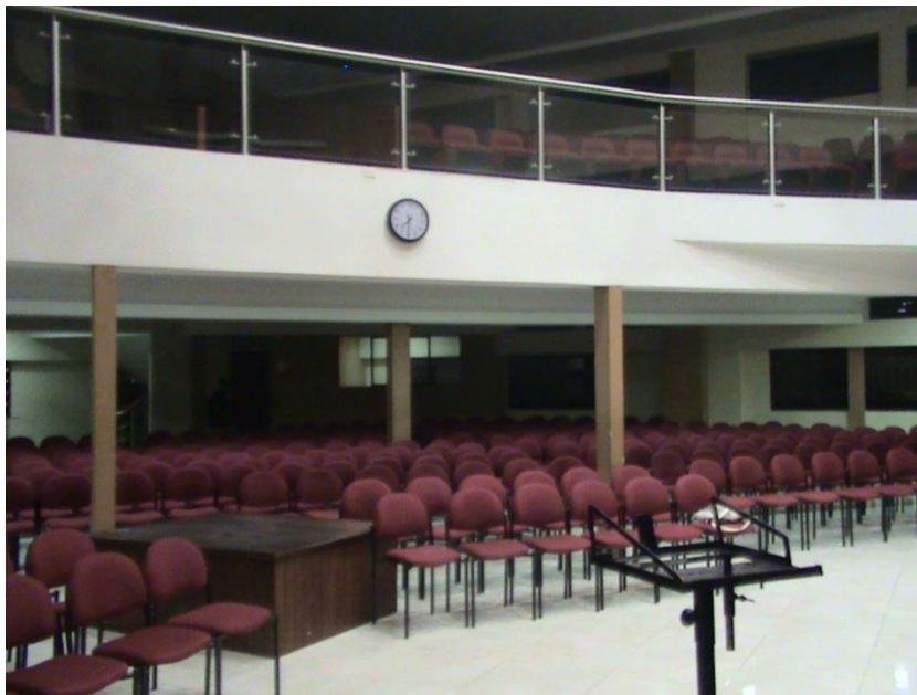
Auditorio y el mezzanine sobre vigas metálicas:
