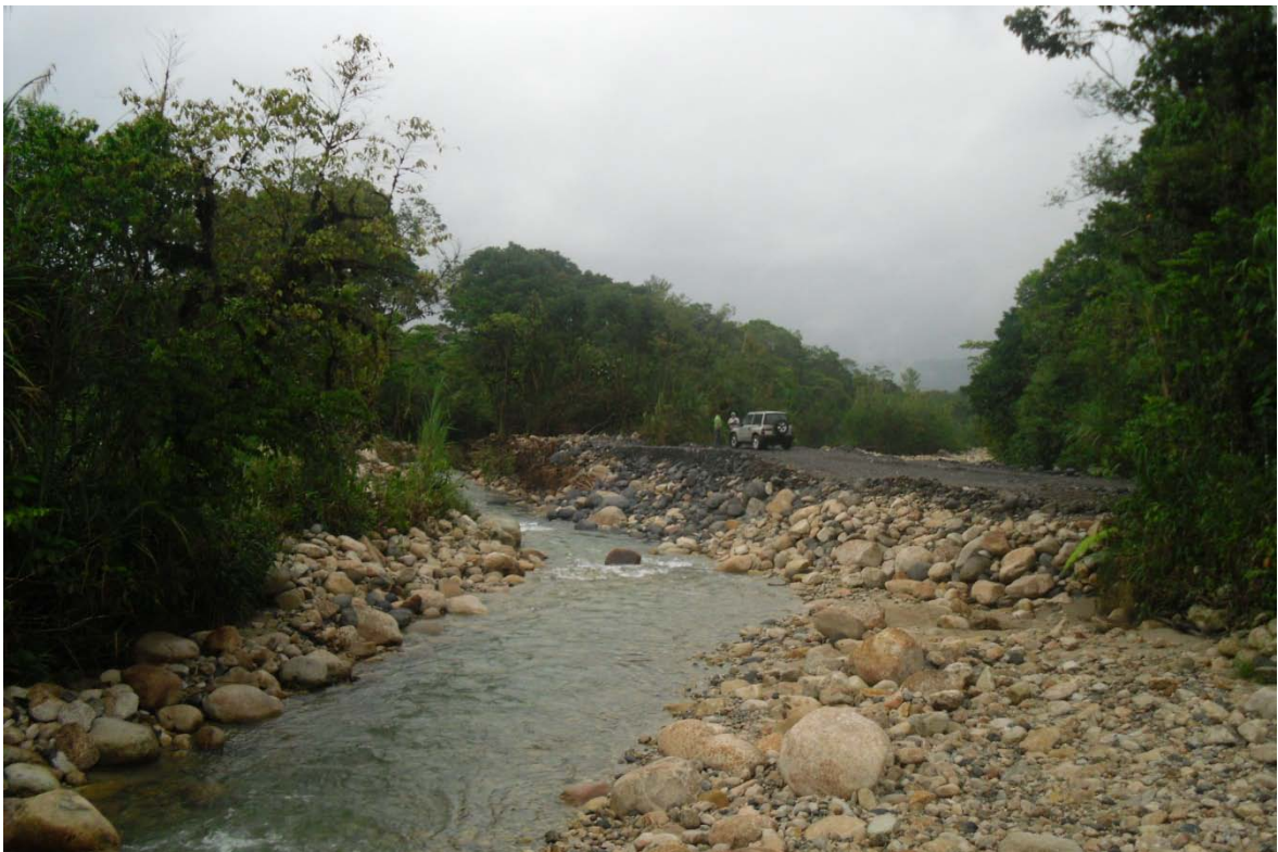
Vista Aguas Abajo desde el Puente peatonal existente
