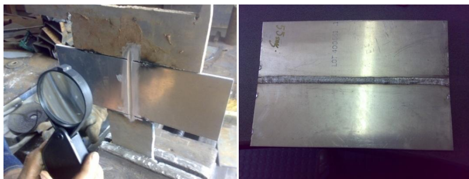
Figura 6.14 Inspección visual entre cada pase de soldadura
