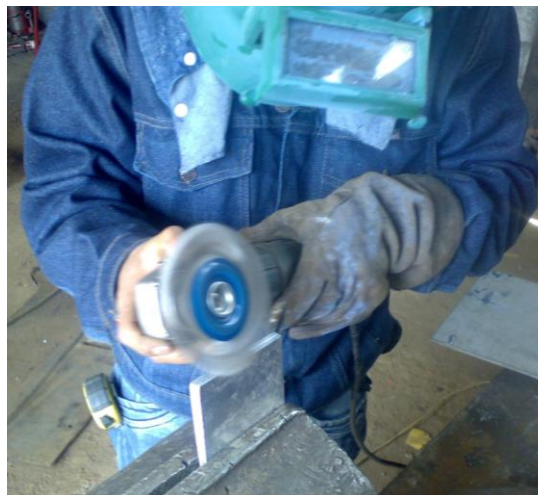
Figura 6.11 Preparación de bordes para soldadura
