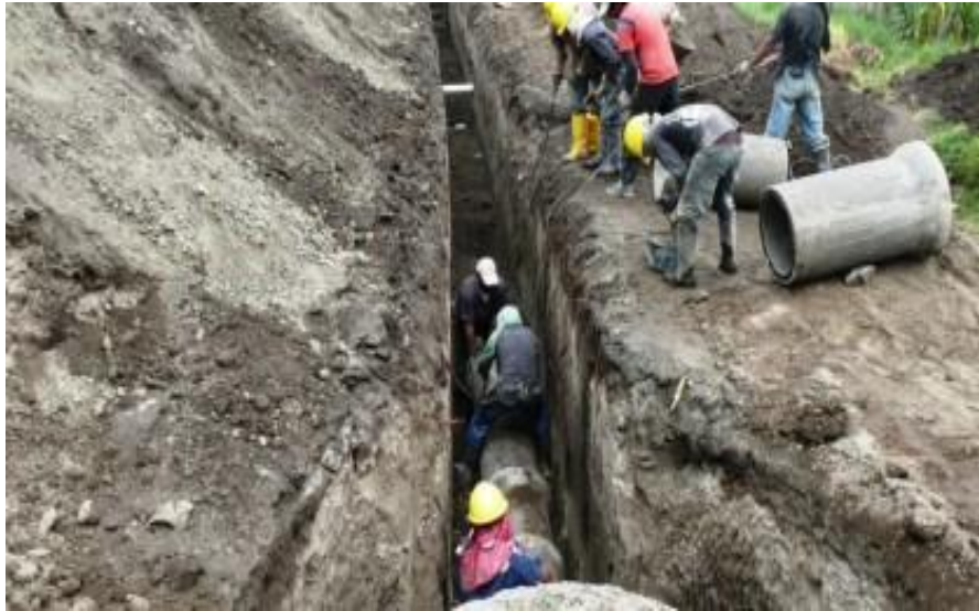
Figura 1.- Colocación de tubería de hormigón en un sistema de alcantarillado
