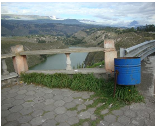
Foto N° 09 Tachos de basura en mal estado
