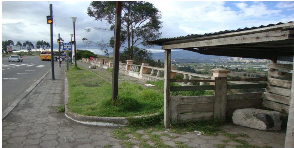
Foto N° 08 Inexistencia de Señalética
