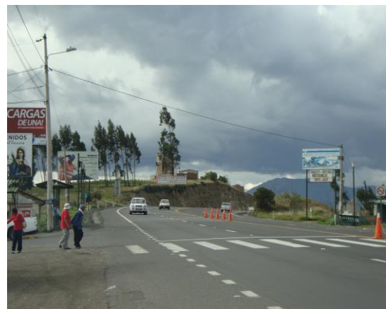
Foto N°10 Inexistencia de un Puente Peatonal
