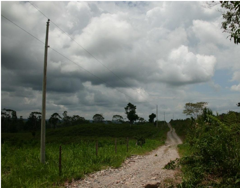
Calzada lastrada con un ancho promedio de 5m y 6m.
