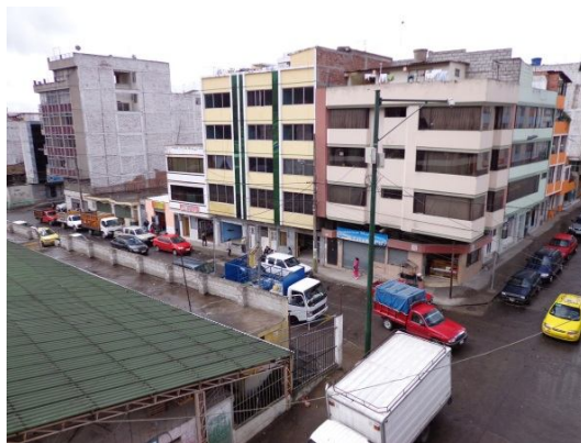
Vista aérea del tramo anterior.
