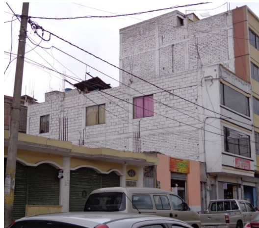
La pared de esta edificación es medianera, a pesar de ello tiene ventanas hacia el colindante.
