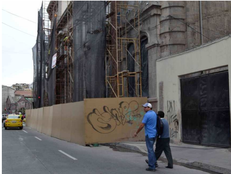
Fig 40. Trabajos sobre la vía, Calle Lalama.
