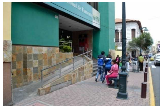
Fig 42. Edificio Banco de Fomento.
