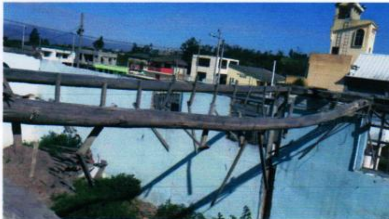
Figura 3 Vigas principales de la anterior estructura del techo.
