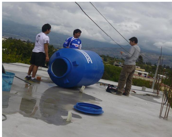
Fotografía N°7. Demostración de la limpieza de un tanque elevado
