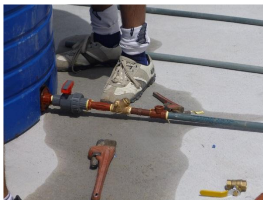
Fotografía N°11. Inspección de la instalación
