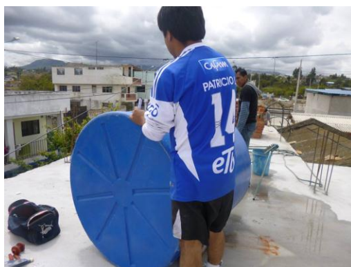
Fotografía N°10. Instalación del tanque elevado en la casa de la beneficiaria
