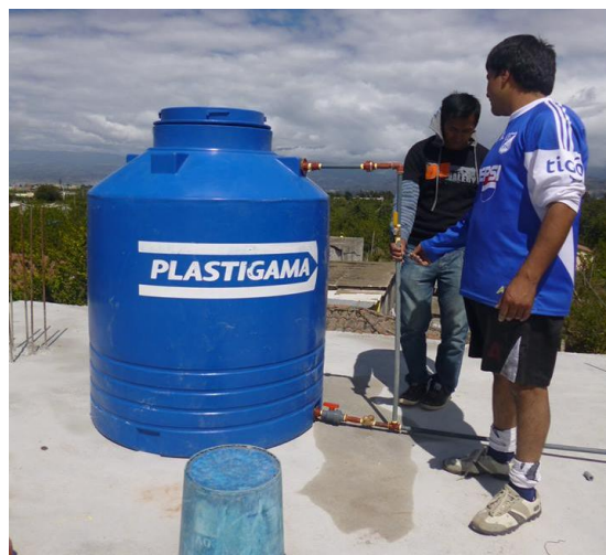
Fotografía N°3. Implementación del tanque elevado en una casa del sector
