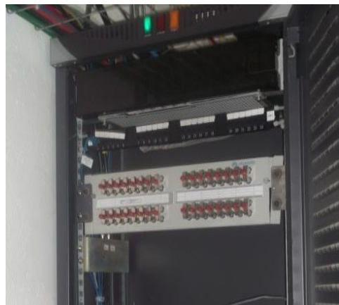
Entradas de fibras y E1 a los equipos
