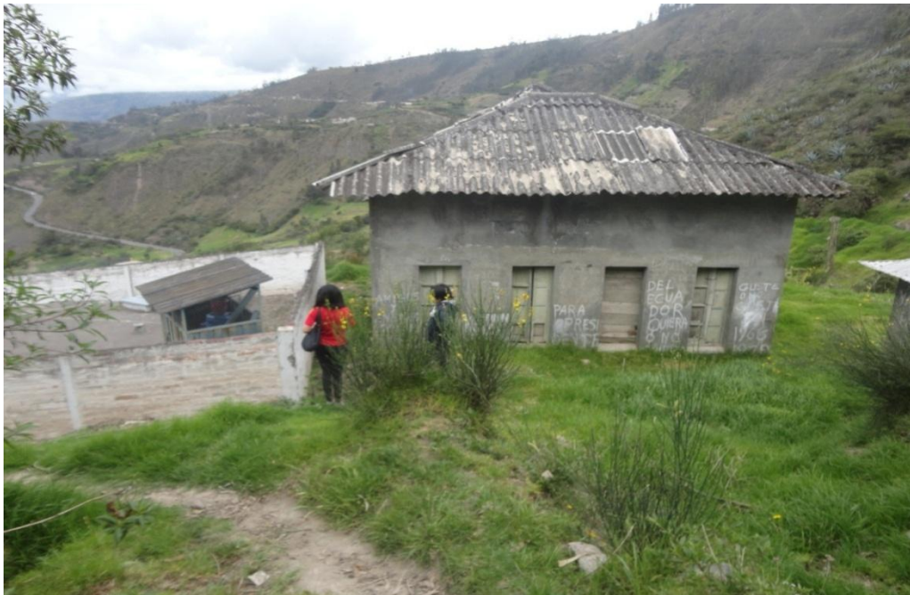
Antigua empresa eléctrica del Cantón Pelileo
