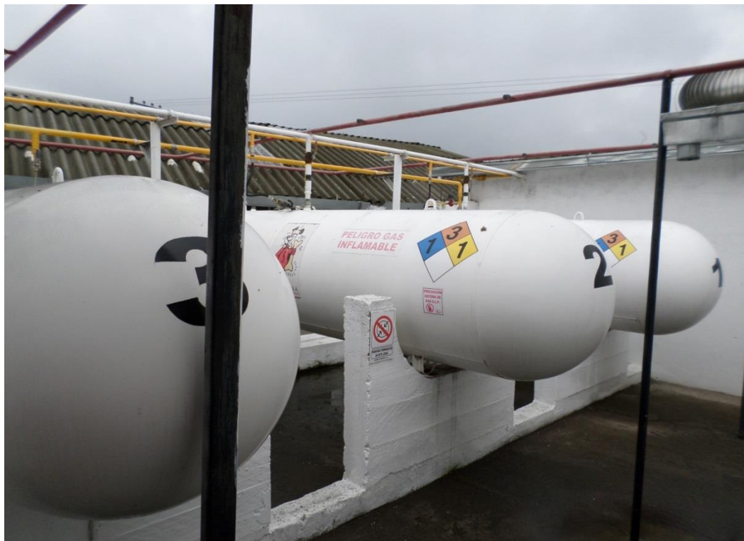
Gráfico # 3: Sistema de almacenamiento de GLP
