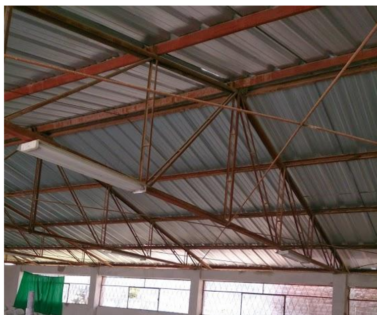
Condiciones de la estructura metálica existente
