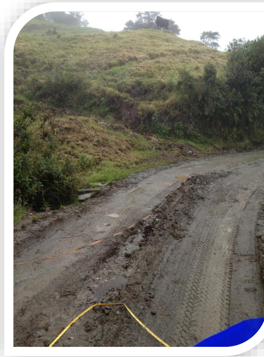
Estado actual de la vía
