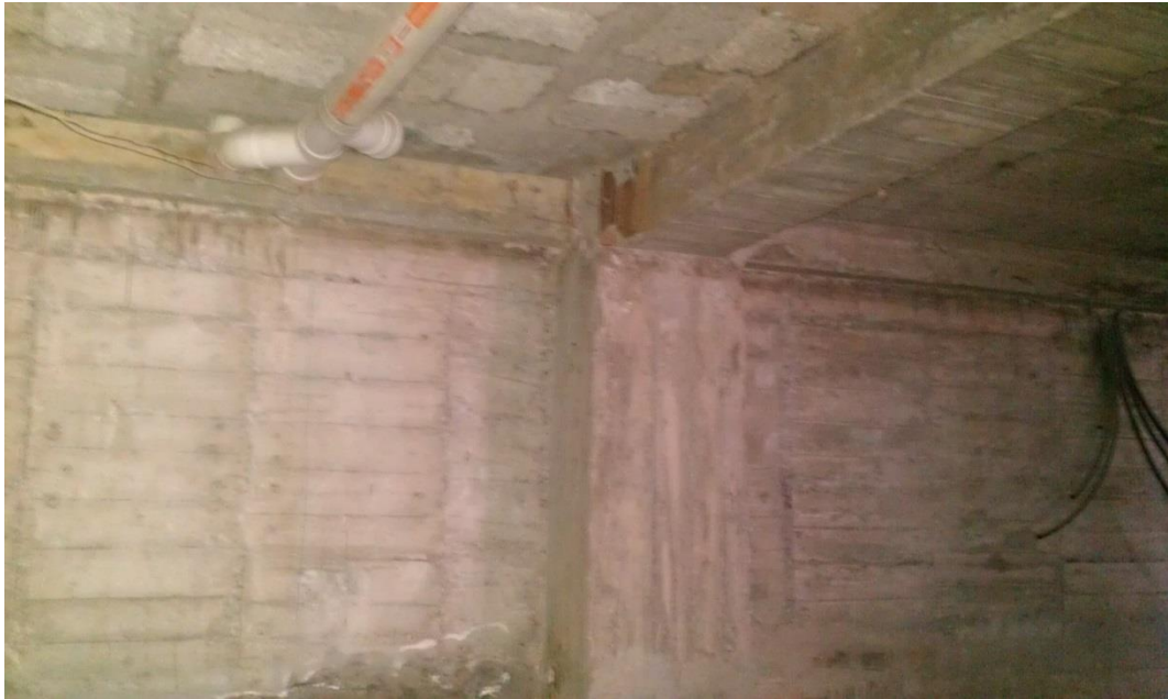
Fotografía N° 3. Nivel 0+00 Losa alivianada y muro de sótano perimetral
