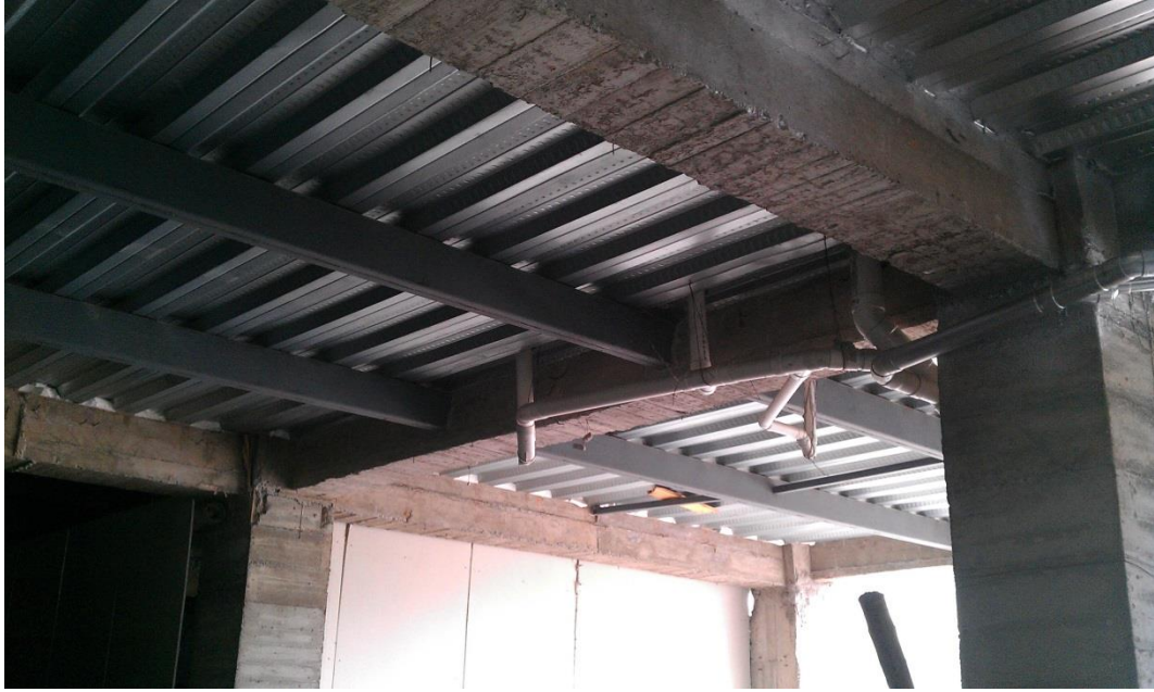
Fotografía N° 5. Distribución de vigas principales (Hormigón Armado) y vigas secundarias (Metálicas)
