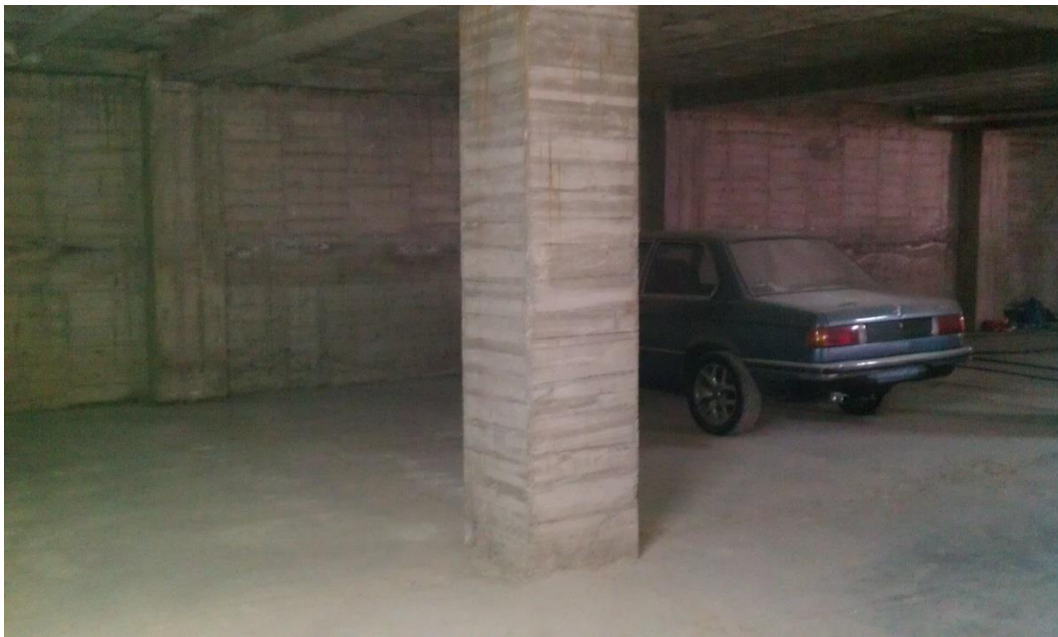
Fotografía N° 2. Nivel - 2.70 piso subterráneo, columnas de 55x55 cm.
