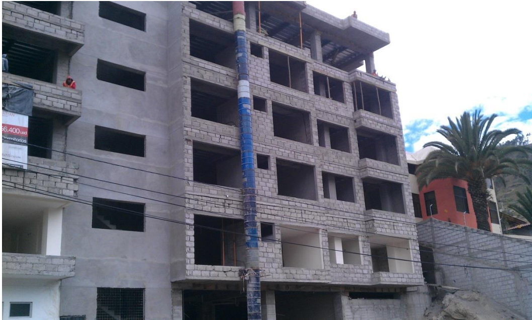
Fotografía N° 1. Vista frontal del edificio en construcción
