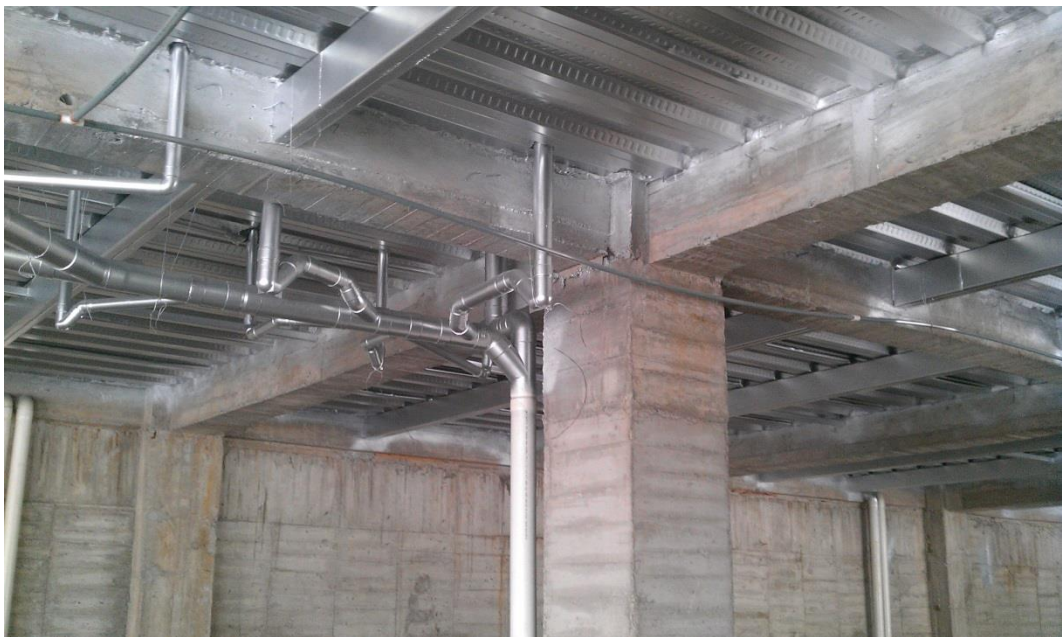
Fotografía N° 6. Distribución de vigas secundarias (Metálicas) en sentido Y-Y
