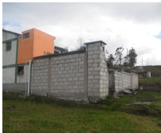
Viviendas de Comunidad
