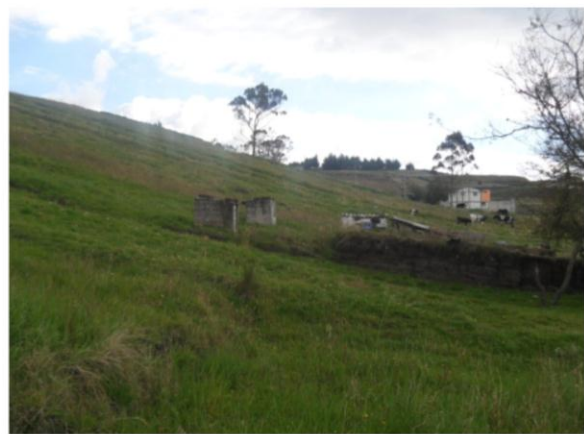
Conducción de Alcantarillado
