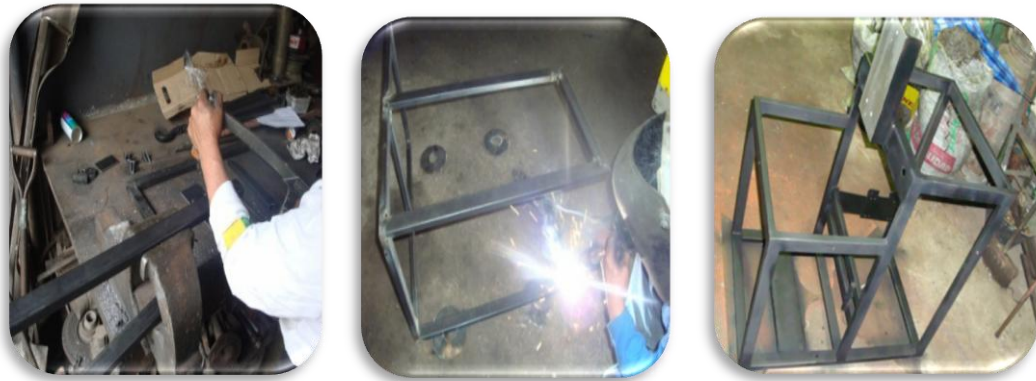
Figura. 6.41 Construcción de la estructura
