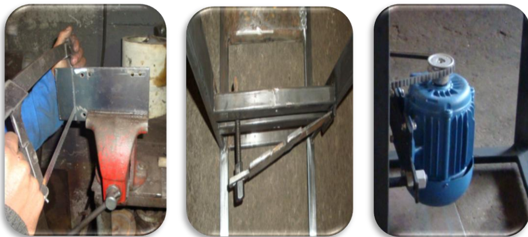
Figura. 6.47 Construcción de la base del motor
