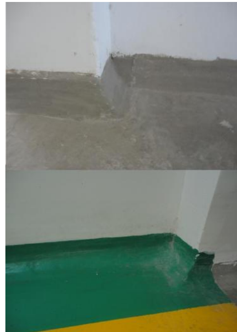
Imagen 12. Después, Unión de la pared con el piso en forma cóncava
