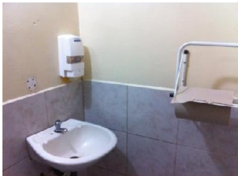
Imagen 25. Antes, Estación de Lavado de Manos
