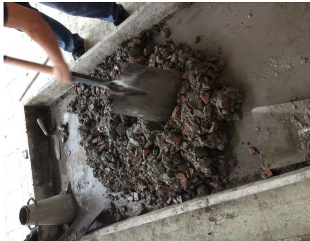
Fotografía N° 11.- Preparación del hormigón a base de ladrillo.
