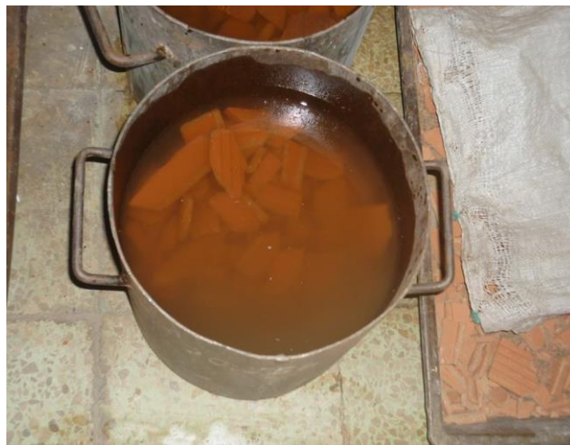
Fotografía N° 4.- Hidratación del ladrillo prensado.
