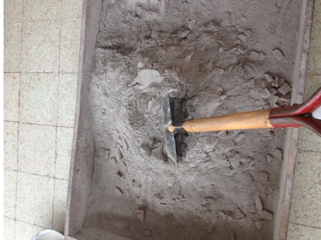
Fotografía N° 10.- Mezcla de los materiales.
