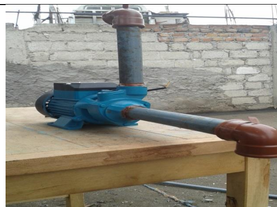
Etapa de montaje (instalación de tubería)
