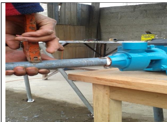
Etapa de montaje (instalación de tubería)
