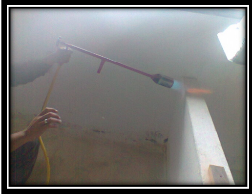
Flameado de paredes y pisos
