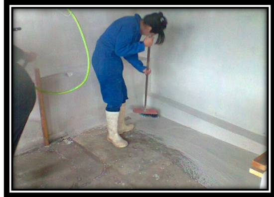
Desinfección con cal
