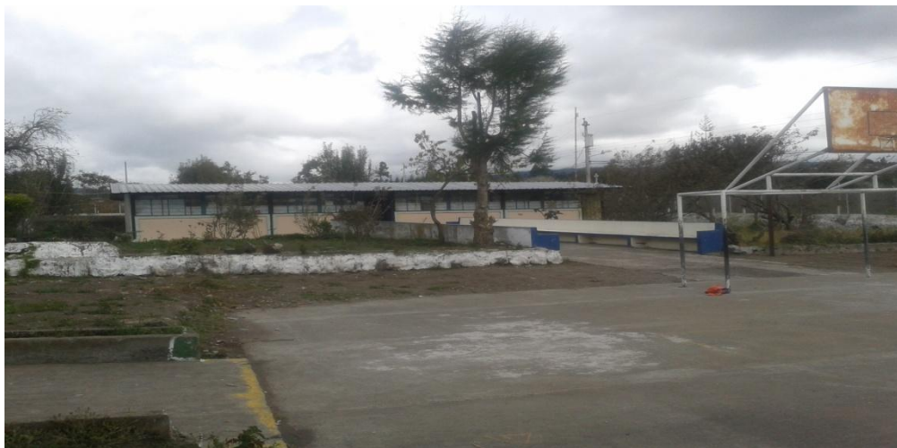
Fachada de interna de la escuela “Gonzalo Grijalva” Fuentes: Escuela “Gonzalo Grijalva” Elaborado por: Galo Rodrigo Sánchez Guerrero
