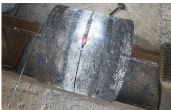
Figura 6.29 Limpieza de la junta precalentada con el uso de un cepillo de alambres.
